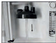
Рис. 49 – Расположение фильтра грубой очистки
